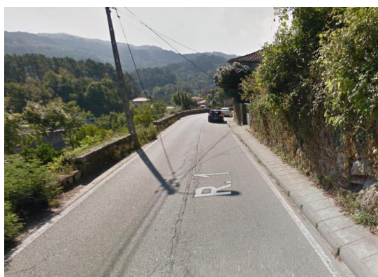
Figura 5. Exemplificação de passeios inexistentes ou com dimensões reduzidas
